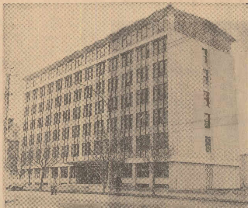
De curînd a fost dat în folosința studenților timișoreni noul local al Facultății de construcții din cadrul Institutului politehnic. Noua clădire modernă întregeste peisajul orașului Timișoara
