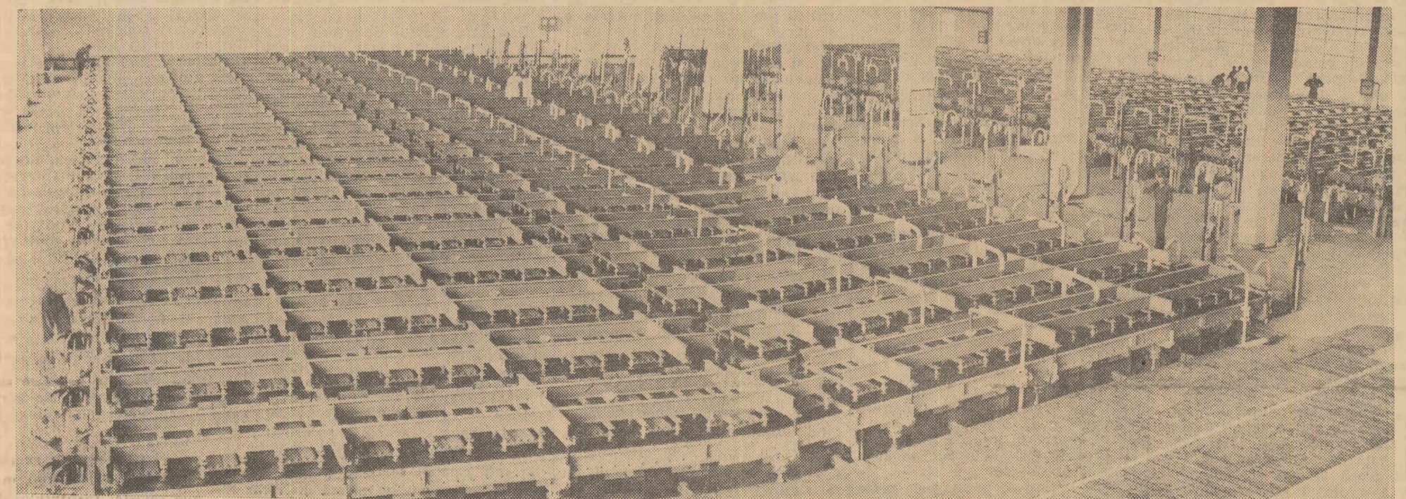
O vedere interioară a secției de electroliză cu catod de mercur
