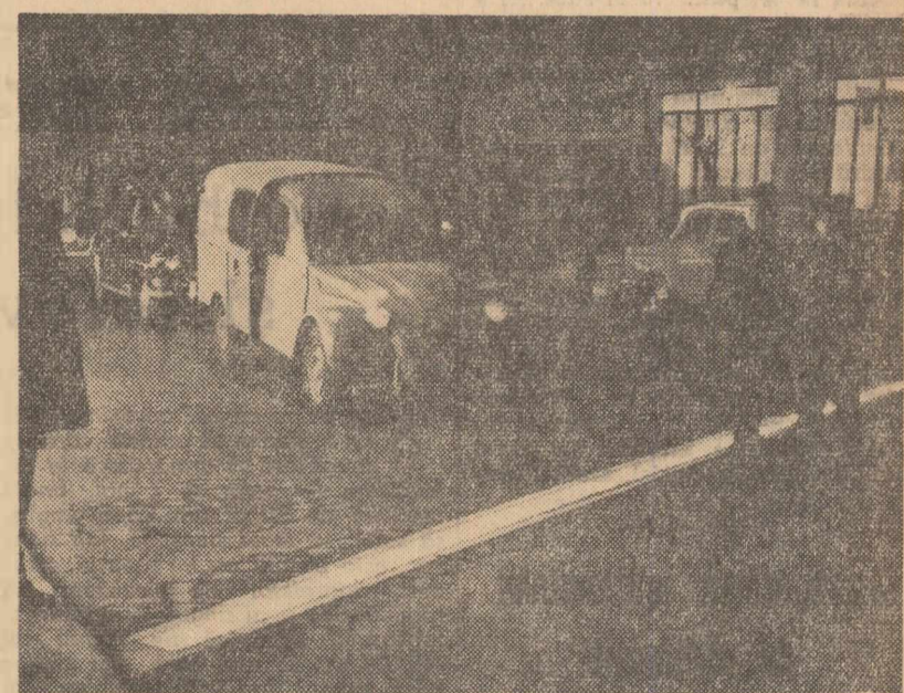
La Perreux, în apropiere de Paris, a fost instalat o bandă formată din carouri luminoase, destinată să marcheze delimitarea unei porțiuni de traversare pentru pietoni. Legată de luminile de semnalizare, această bandă este făcută din plăci prevăzute cu tuburi fluorescente și acoperite cu dale din sticlă groasă de 4 cm. Potrivit cu lumina, ele se colorează în orange, roșu, verde
