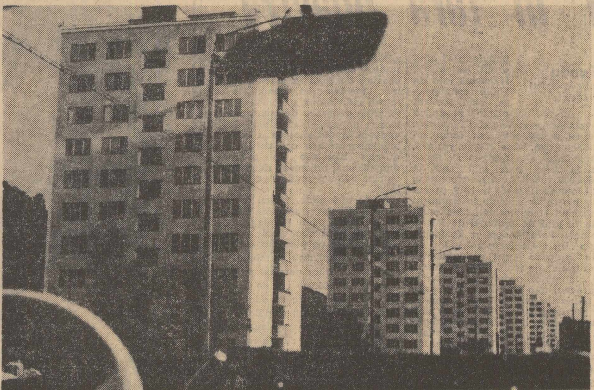
Constructorii trustului regional Cluj au ridicat la poalele Cetățuiei blocuri de locuințe elegante și confortabile. În cișeu: o parte din aceste blocuri Foto: MIHAI POPESCU
