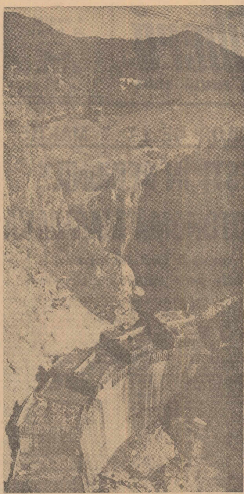
La Hidrocentrala „16 Februarie” de pe Argeș: Vedere a barajului
