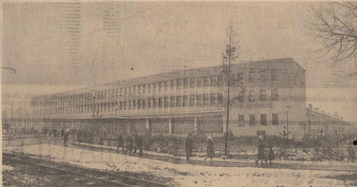
Aspect exterior al întreprinderii IPROFIL Arad
