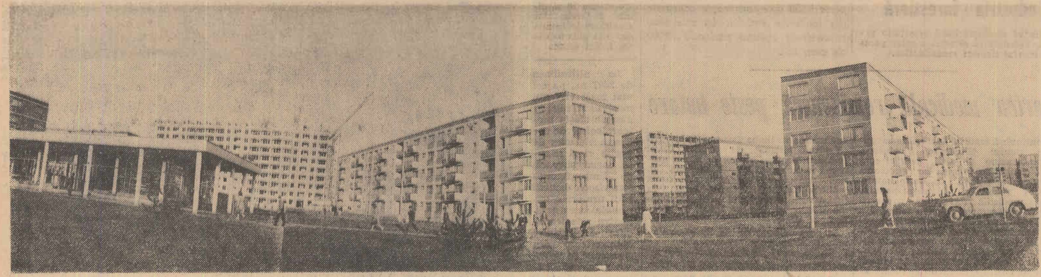
Blocuri noi în Lunca Pomostului din orașul Reșița
