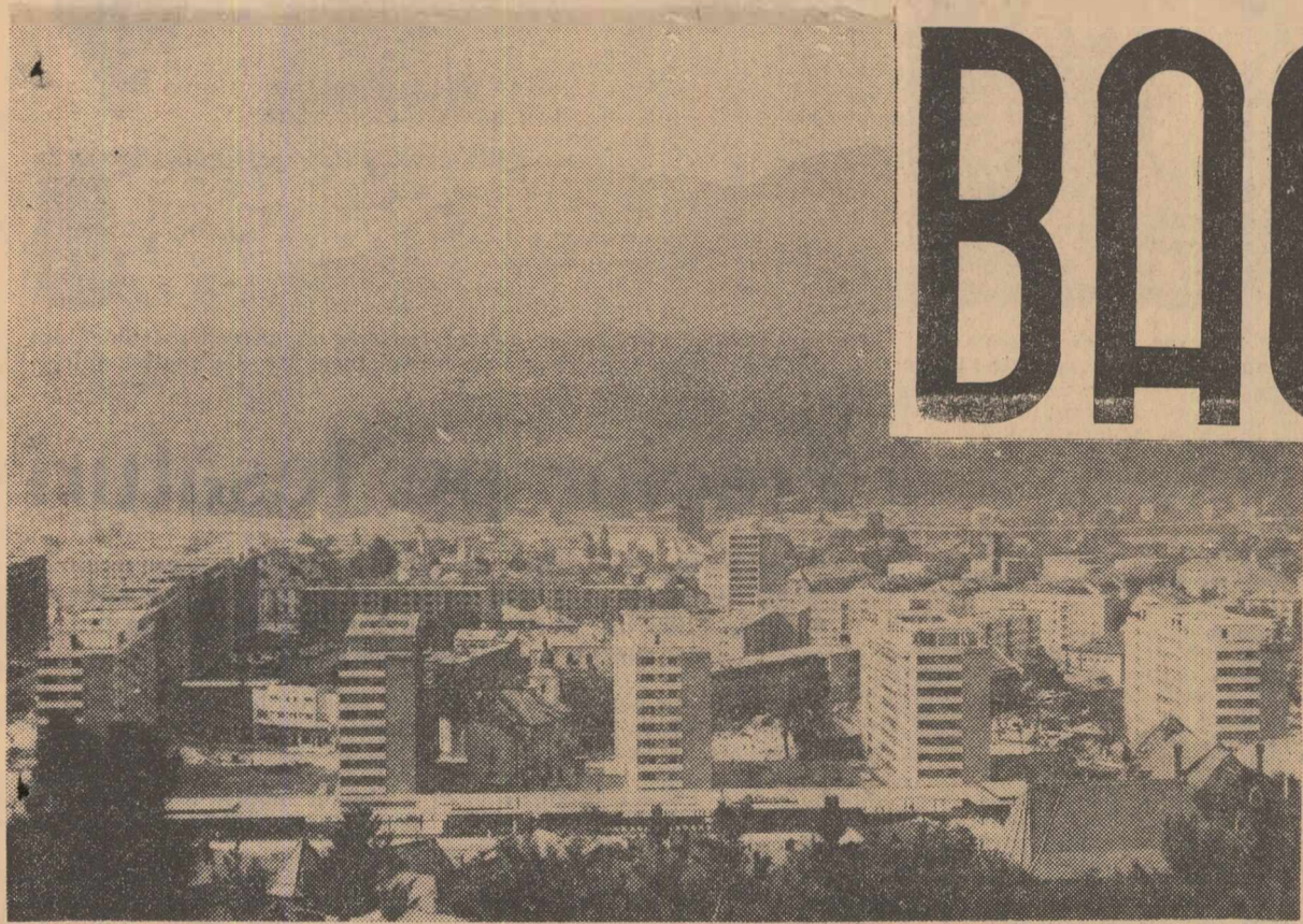
Orașul Piatra Neamț se transformă din temelii. Aici se înalță zeci de blocuri moderne cu mai multe etaje
