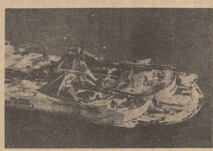
Pe o fișe de țărîm inundabilă din apropierea portului Sydney din Australia se construiește o nouă operă. Acoperișul acestei opere, care va fi boltit și va avea forma unei scole se compune din 136 de arce imbinabile între ele, în greutate totală de 21.000 tone. La punctul cel mai înalt al acoperișului construcția va atinge nu mai puțin de 70 de metri. Fotografia de mai sus, luată din avion, înfățișează un aspect de pe șantierul de construcție al noului edificiu.
