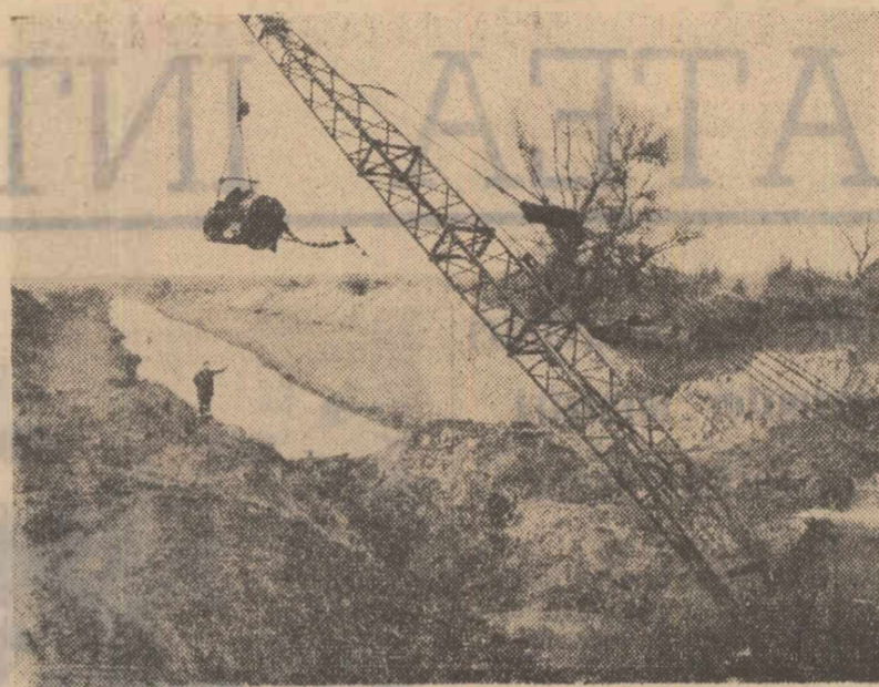
Imagine a viitorul canal principal de evacuare din balta Borcei de jos Foto: I. ARABOLU
