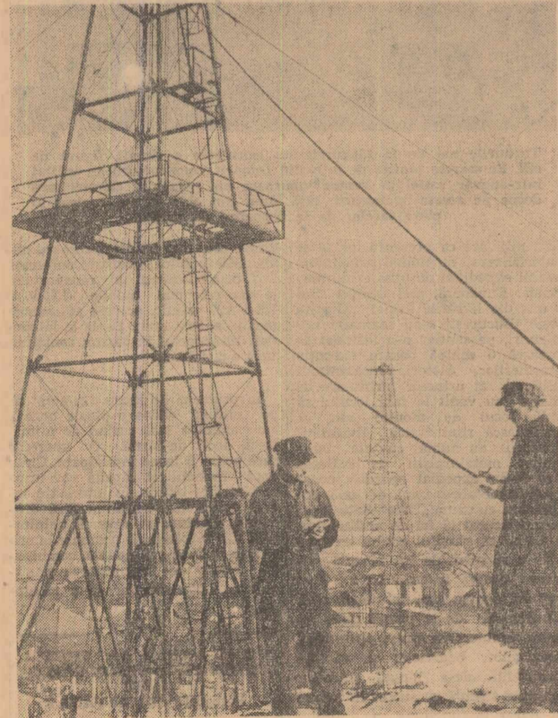
Procedul modern de extragerea sării pe cale umedă aplicat în exploatarea salină Tg. Ocna și în alte puncte similare din țară, oferă posibilitatea obținerii unei productivități ridicate, permițînd totodată exploatarea zăcămintelor la adîncimi mai mari. În cliseu: Șeful secției Gura Șlănicului de la exploatarea Tg. Ocna, Alexandru Popoiu, discută cu șeful de echipă Constantin Aparachevi despre lucrările de intervenție la o nouă sondă.
