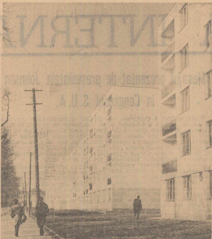
Construcții noi la Focșani
