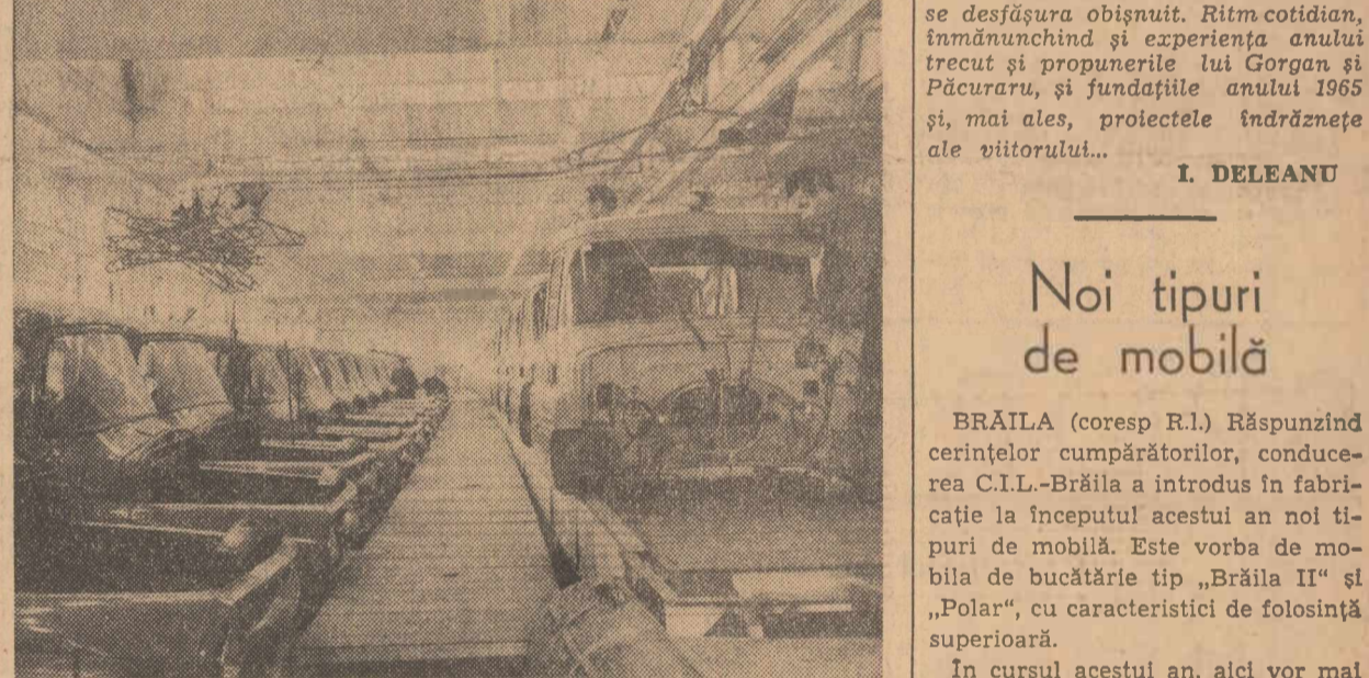
Vedere generală din modernă hală unde se montează cabinele autocamioanelor
