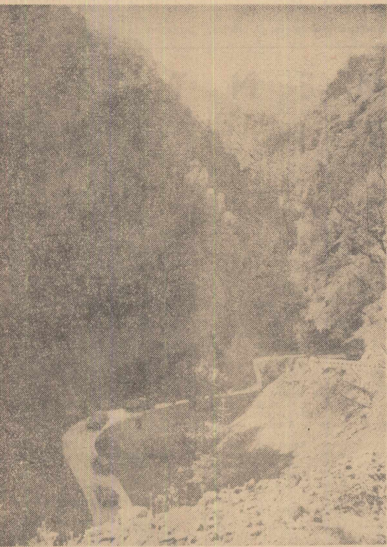
Pe șantierul hidrocentralci „16 Februarie” de pe Argeș, constructorii au dat în folosință o șosea modernă, situată la mare altitudine. În clișeu: vedere panoramică a unei porțiuni din noua șosea
