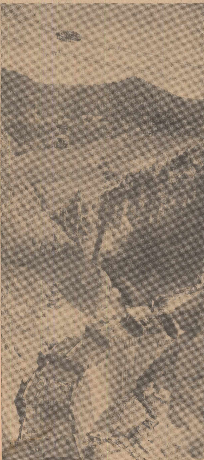
Pe șantierul hidrocentralei „16 Februarie” Argeș, turnarea barajului continuă într-un ritm susținut. În fotografie: vedere asupra barajului Foto: NICU VASILE
