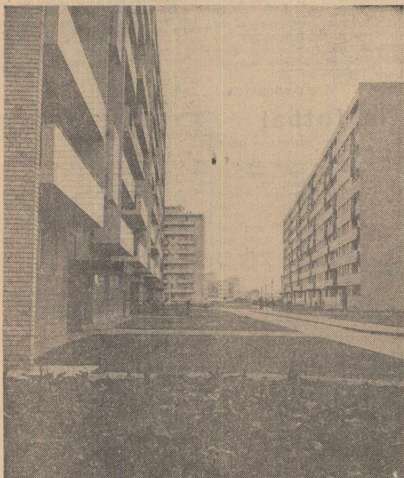
Construcții de noi blocuri de locuințe în cartierul Drumul Taberei din București. Foto: AGERPRES
