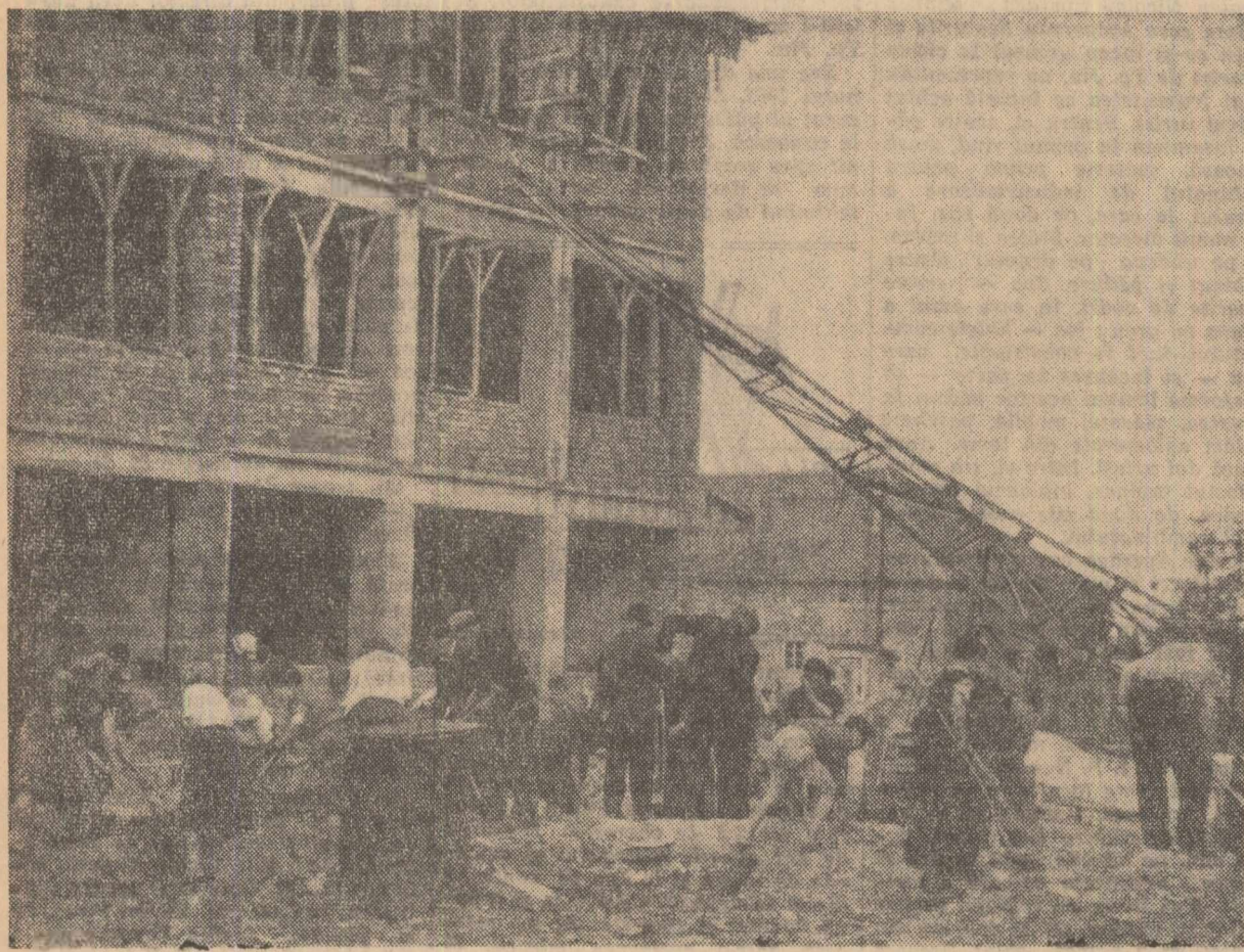
La construcția școlii de 8 ani din cartierul 11 Iunie (Sibiu) își dau sprijinul numeroși cetățeni din cartier. Noua școală, clădire solidă cu 2 etaje, va fi dată în folosință anul acesta. În cișeu: O imagine obișnuită de pe șantierul noii școli.
