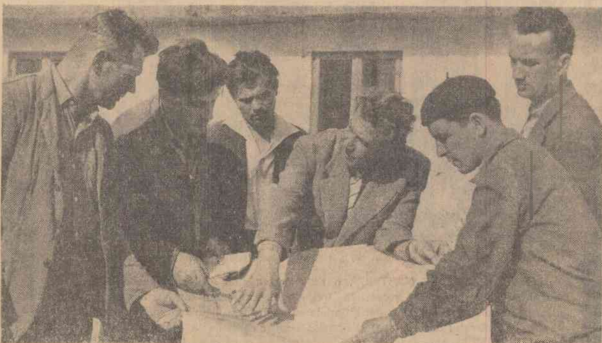
A doua zi urma să se țină consfătuirea de producție. Împreună cu cîțiva constructori, seful lotului nr. 1 mai revinde planurile de lucru. De la stînga la dreapta: dulgherul Fr. Vereș, lăcătușul-montaj D. Sima, maistrul mecanic D. Ștefan, ing. A. Benedek, maistrul principal Gh. Ionescu și seful de echipă A. Păun. Foto: NICU VASILB
