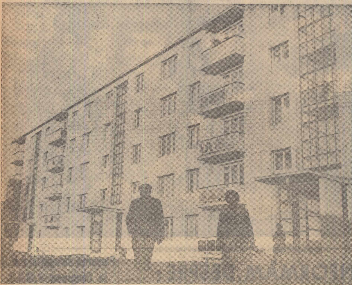
Marele Combinat de industrializare a lemnului de la Blaj a determinat nu numai schimbarea înfățișării istorice „Cămpii a Libertății”, ci și a orașului. Aici, se construiesc acum numeroase locuințe, destinate în mare parte lucrătorilor combinatului. În dreapta: Un nou bloc de apartamente în apropierea combinatului. Foto: A. CONSTANTINESCU
