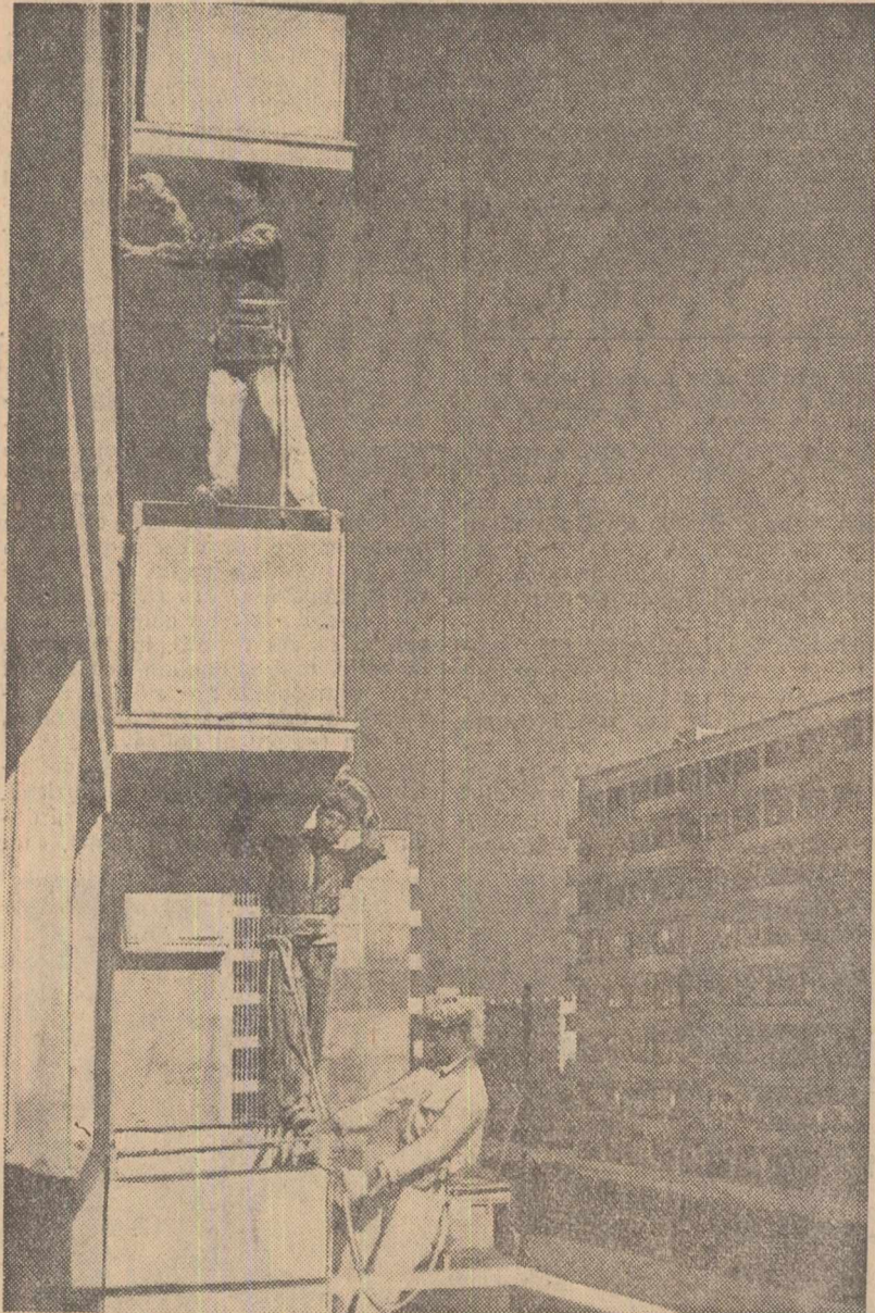
In aceste zile, pe șoseaua Giurgului din București se lucrează de zor. În curând, noi blocuri vor fi gata să-și primească locatarii. Iată, în clișeu nostru, cițva membri ai brigăzii de zugrăvi condusă de Valentin Podleșao, lucrind la finisarea unui bloc.
