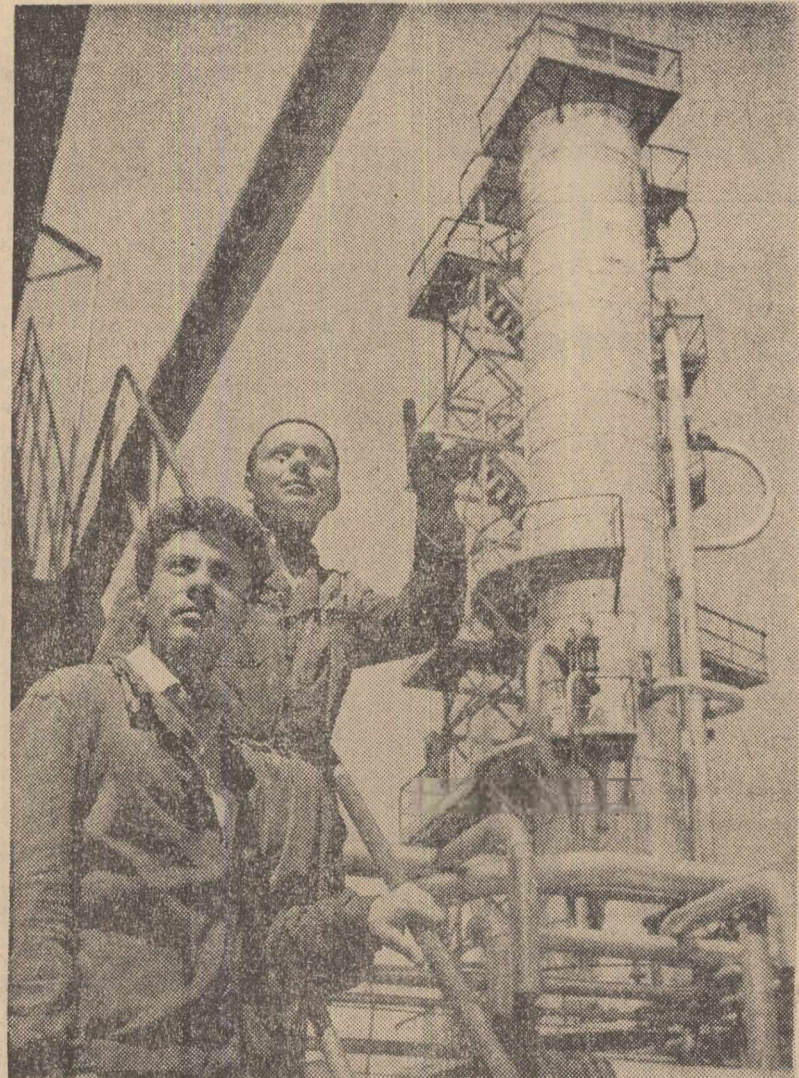
Fotistul Ion P. Ionță și Ștefan Mihalache de la tabloul de comandă al instalației ce a fost reînălțată la Rafinăria Ploiești
