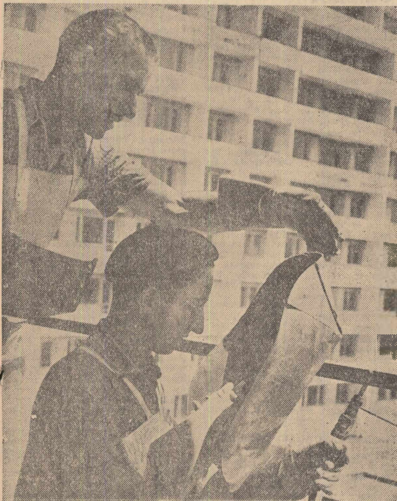
Zilele acestea în blocurile de pe șantierul Gluilești-Stadion din Capitală se vor muta alți noi locatari. Iată pe harnicii sudori-construcători: Victor Achim și Ion Puzdrea, statornicind scheletul mecanic de la balconul unui apartament ce va fi dat în curînd în folosință.
