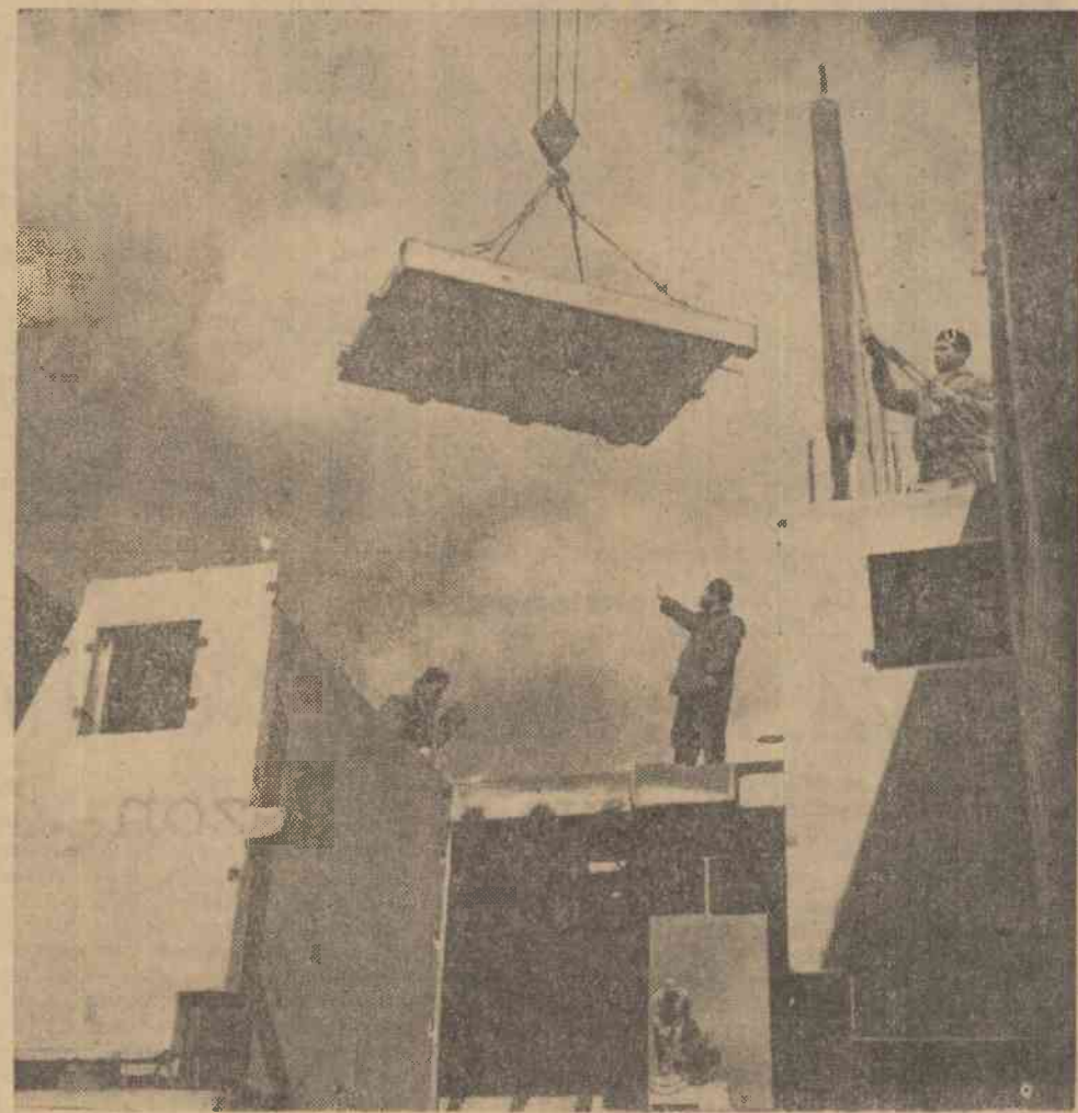
Se montează un apartament pe șantierul de blocuri din panouri mari prefabricate de pe Șos. Giurgiului din Capitală
