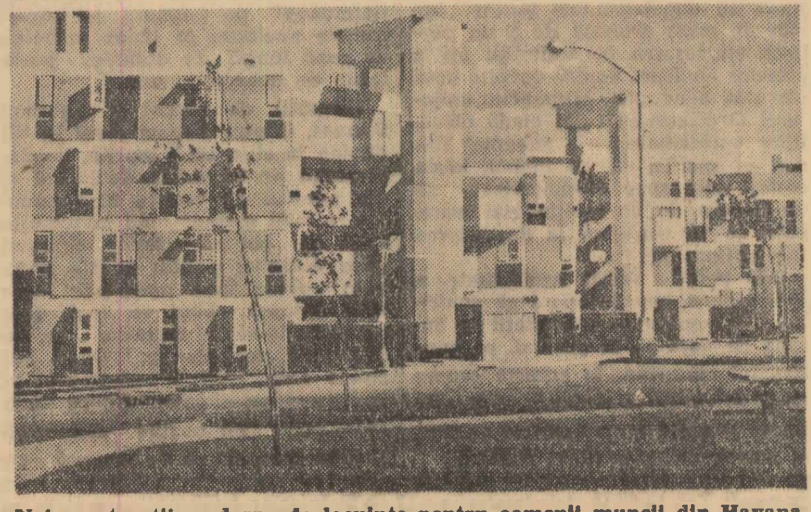
Noi construcții moderne de locuințe pentru oamenii muncii din Havana, capitala Cubei
