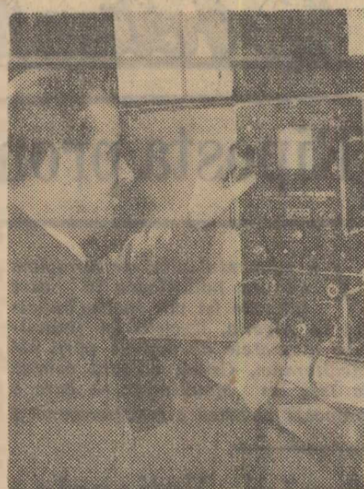
Montatorul Ion Nedelea de la Întreprinderea pentru raționalizarea și modernizarea instalațiilor energetice din Capitală, verifică funcționarea locuitorului de defecte pentru linile de înaltă tensiune
