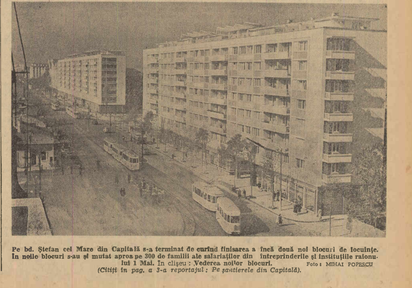
Pe bd. Ștefan cel Mare din Capitală s-a terminat de curînd finisarea a încă două noi blocuri de locuințe. În noile blocuri s-au mutat aproa pe 300 de familii ale salariaților din întreprinderile și instituțiile raonului 1 Mai. În clișeu: Vederea noilor blocuri. Foto: MIHAI POPESCU (Citiți în pag. a 3-a reportajul: Pe șantierul din Capitală).
