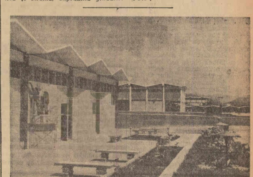
Una dintre noile școli ce se construiesc în centrul școlar Camillo Cienfuegos din Cuba.
