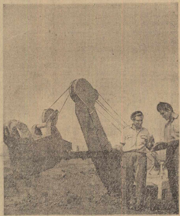
Șeful lotului I, ing. Irion Clurea, discută cu Gheorghe Secară planul de excavație al unui nou sector.
