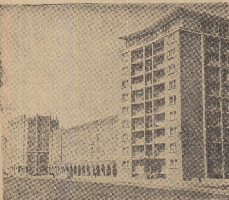
Un aspect al noilor clădiri de pe strada lungă din orașul Rostock, (R.D.G.)
