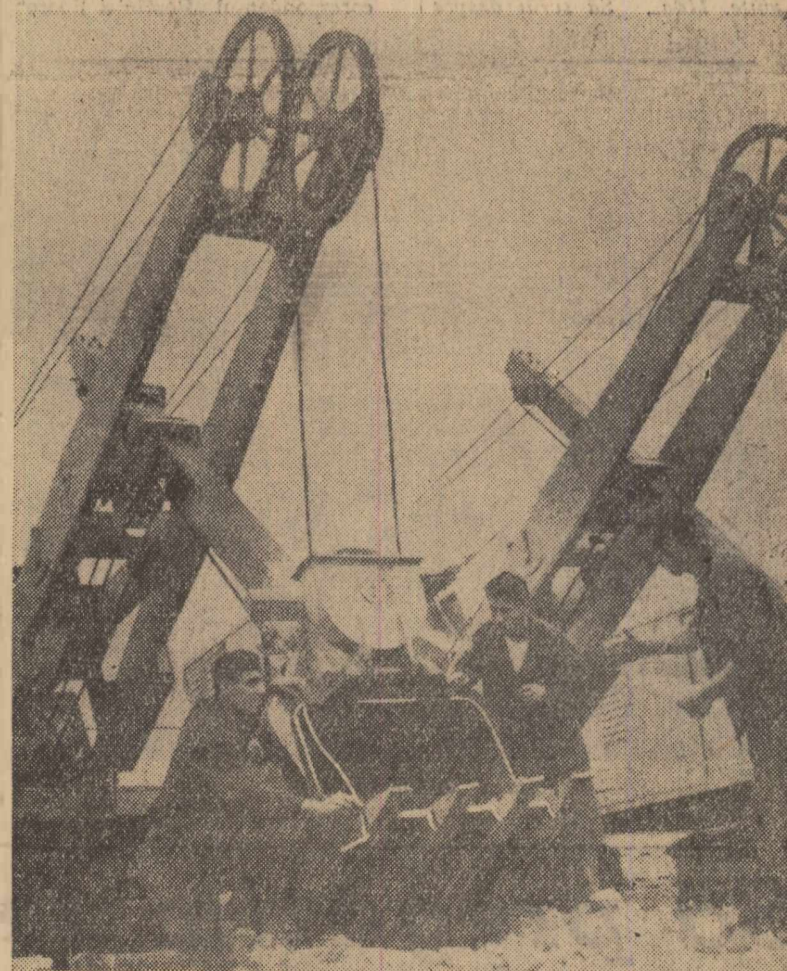
Savin Eugen, șeful brigăzii, împreună cu lucrătorii montori Cupliu Stan și Dinu Marin, făcînd escavatorului de 0,5 m.c. ultimele verificări înainte de a fi dat în exploatare.
