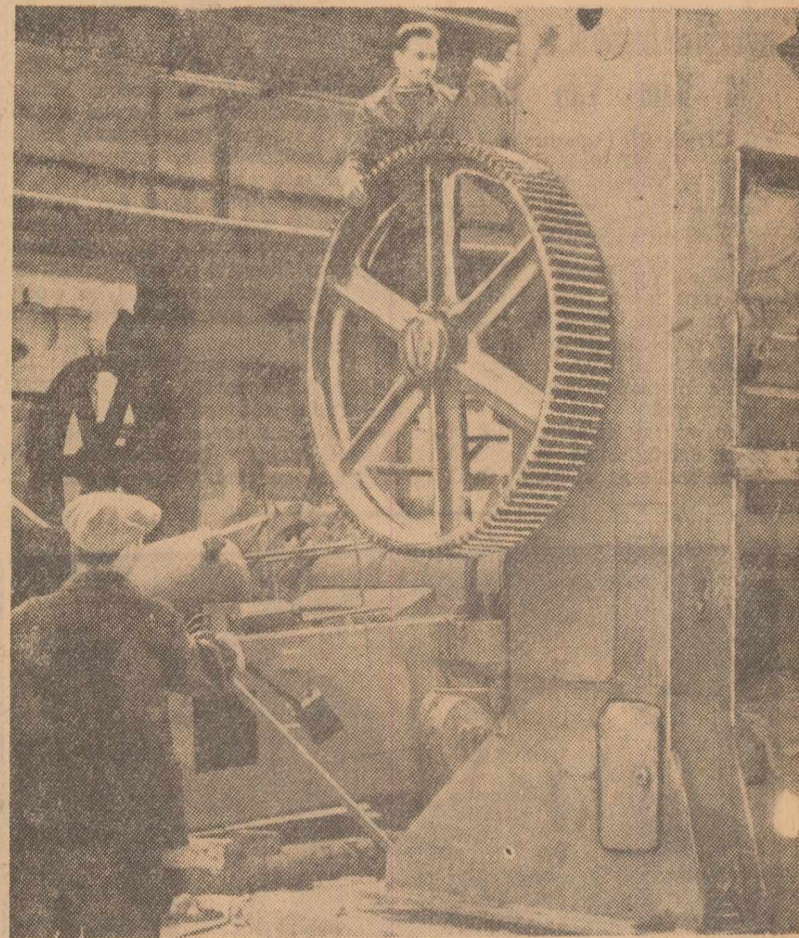
La uzina nr. 1 pentru fabricarea rulmenților din Moscova se montează cea mai mare secție automată din lume care va fabrica rulmenți comili pentru industria de automobile și tractoare. În cliseu: instalarea utilajului de presaj a noii secții automate.
