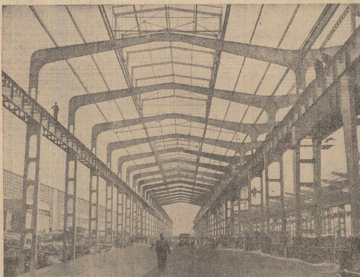
Halele noi secții de laminoare de la Hunedoara au început să se contureze. La linia de profile mijlocii se continuă montarea fermei metalice.
