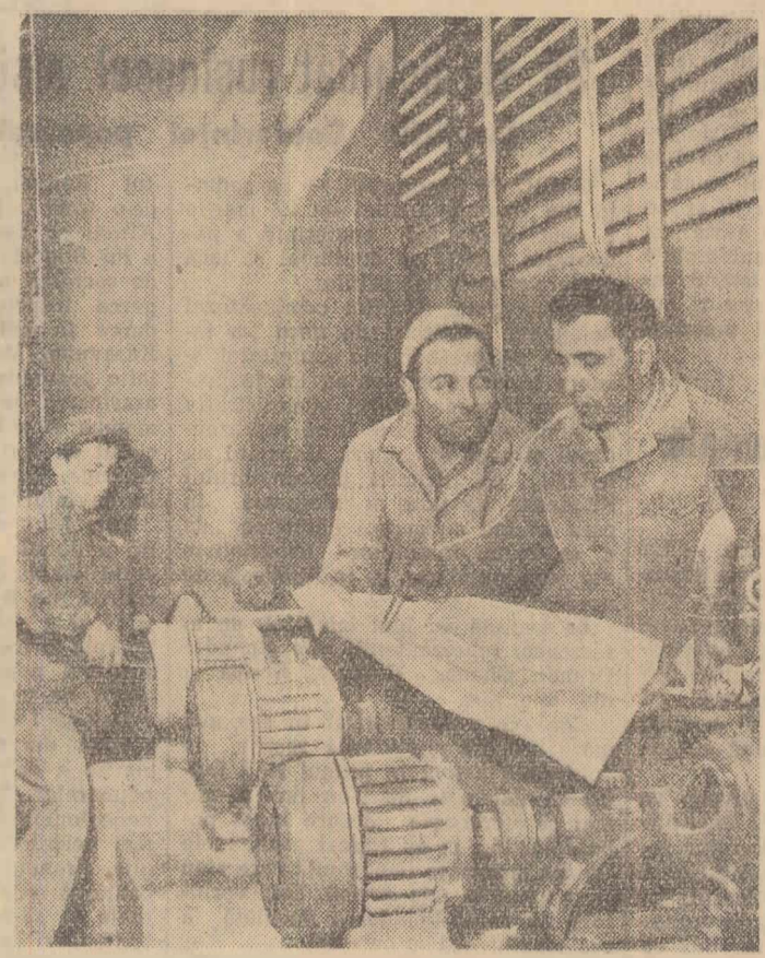
La stația de hidrofor de pe șantierul Gluiești, o parte din echipa instalatorilor sanitarilor condusă de Constantin Stan face ultimele „retușuri” ale instalației. În afara șefului echipei, fotografia noastră îl înfățișează și pe Ștefan Neacsu și pe Ștefan „Junior” care a devenit un instalator de nădejde.
