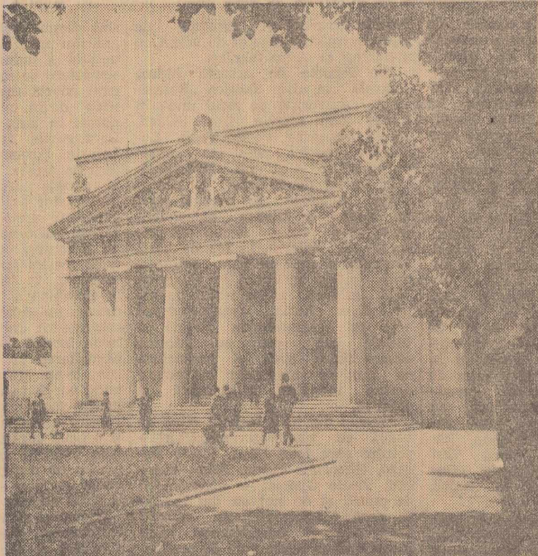
Clădirea Teatrului de Stat din Galați
