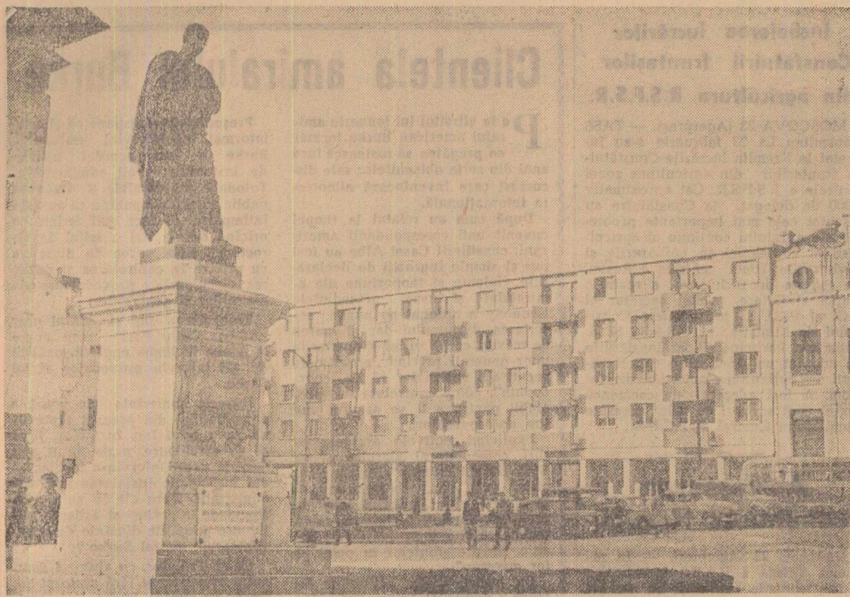
Și în orașul Constanța, ca și în întreaga țară se ridică numeroase blocuri de locuințe pentru oamenii muncii. În clișeu: unul din numeroasele blocuri ce se înalță în centrul orașului
