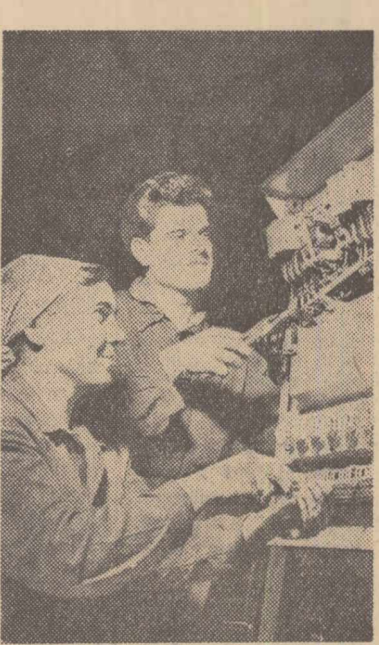
De curind a luat finia în Capitală o nouă unitate a Ministerului Industriei Grele: Întreprinderea de fabricație și montaj ascensoare. Profilul acestui noi unități este acela de a fabrica uliajul și mecanismele necesare ascensoarelor, troliilor etc. În clădire: Monumentul Maria Preda și Ion Revizoru lucrind la un tablou de comandă pentru ascensor.
