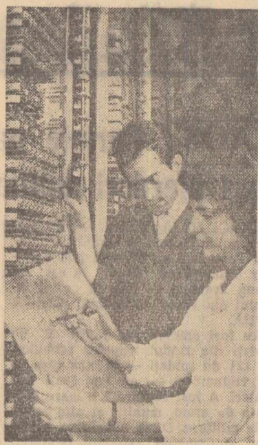
Meseria de constructor de centrale telefonice automate cere din partea muncitorilor de la uzinele „Grigore Preoteasa” o pregătire serioasă. La perfecționarea acestei meserii, aportul cadrelor tehnice este de un real folos.
