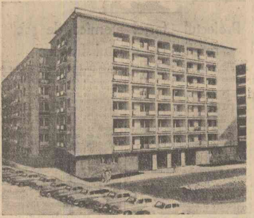
Pe Calea Victoriei s-a terminat zădărnica finalizarea unui nou bloc de locuințe cu 117 apartamente, în care s-au și mutat noli locatarii.
