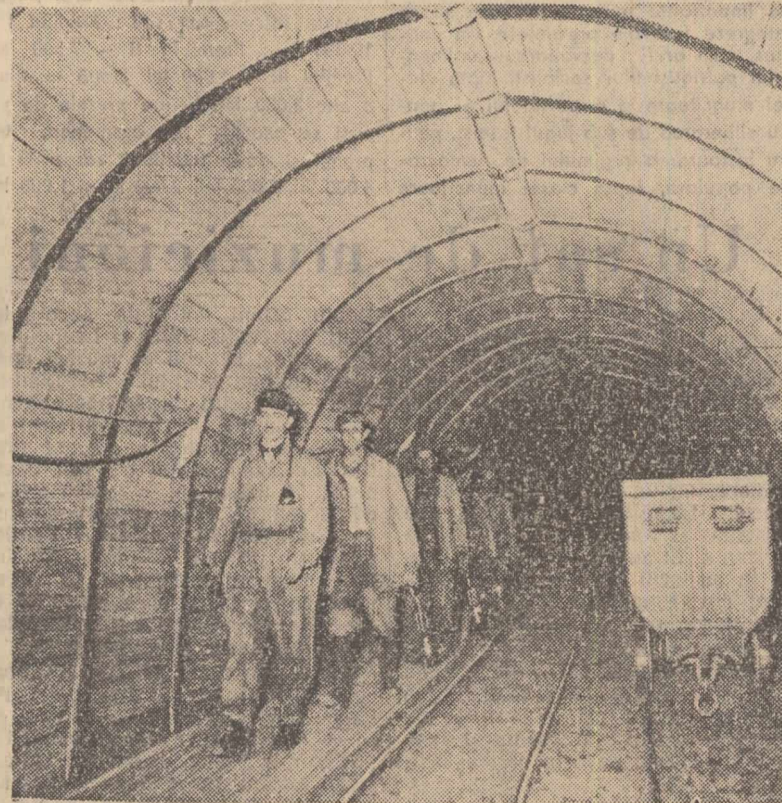
Galerie armată cu grinzii metalice la mina Uricani
