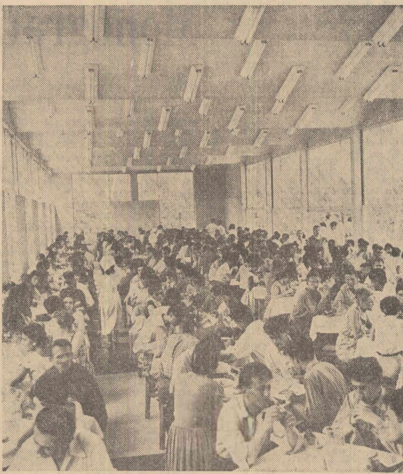
La Costinești, pe malul mării, s-a inaugurat, de curând, cea mai mare tabără studențească din țară. Aici își vor petrece vacanța, în cursul acestui ver, 5.000 studenți. Pentru amenajarea acestei tabere s-au făcut mari lucrări de canalizare, electrificare și introducere a rețelei de apă. S-au construit drumuri, alei asfaltate, kilometri întregi de trotuare. Totodată, s-a construit o încăpătoare cantină înzestrată cu utilaj ultramodern.
