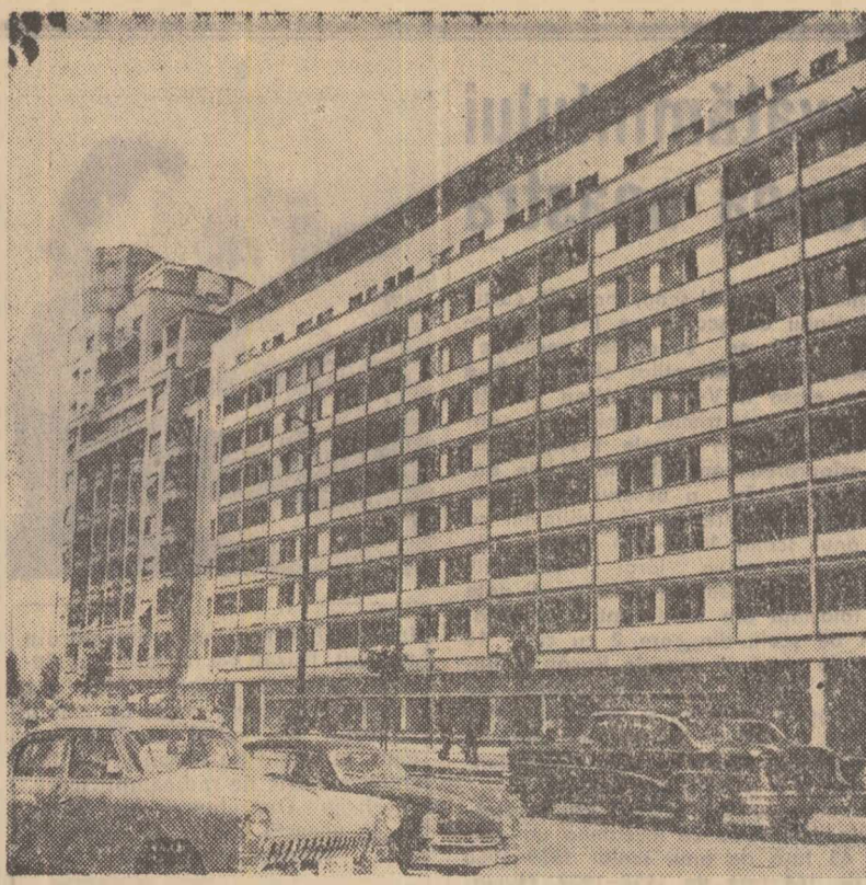
Constructorii întreprinderii nr. 5 construcții-montaj au ridicat pe bd. Magheru un bloc cu 9 etaje, cu un număr de 182 de apartamente. Zilele acestea ei au dat scheletul jos, scoțînd la iveală fațada blocului care dămină și a început să primească noul său locatar. În momentul de față, la parter se instalează mobilierul celui mai mare magazin cu autodeservire din țară, care va avea o suprafață de 550 metri pătrați.
