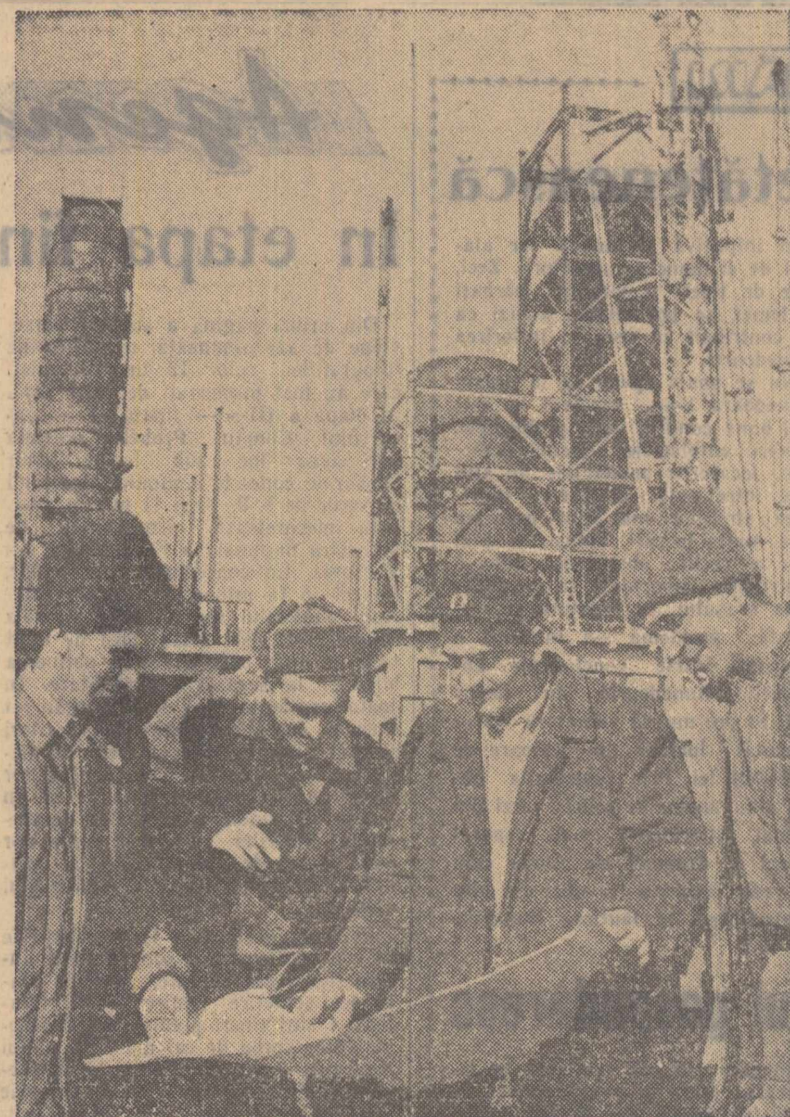
La rafinăria nr. 10 Onești s-a terminat construcția primei instalații de cracare catalitică. E în curs de construcție cea de a doua instalație de acest gen. În cliseu: A. Alexandru Berbec, șef de echipă, Nicolae Dan, șef de brigadă, Gh. Voinea, inginer și Nicolae Păun, șef de echipă, se consultă în vederea unei noi ridicări a reactorului de 60 de tone pe construcție. Foto: NICU VASILE
