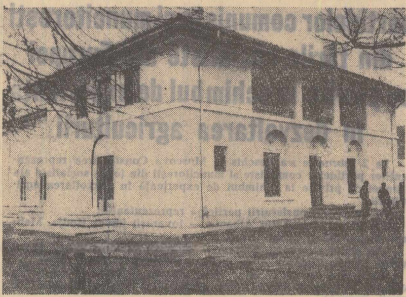
Clădirea de mai sus înfățișează Casa de cultură din Tg. Ocna, regiunea Bacău, dată în folosință la sfîrșitul anului trecut.
