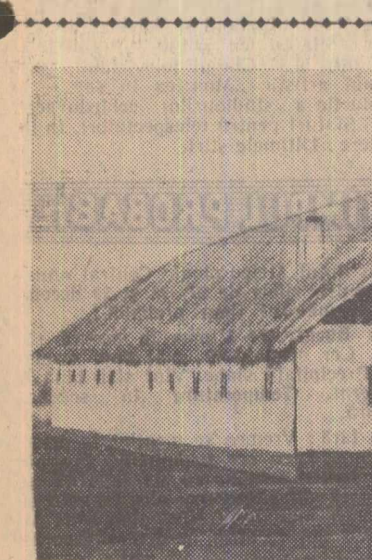
Cliseul nostru prezintă unul dintre grajdurile construite anul acesta în raionul Gura Jiului cu materiale din resurse locale și anume pe cel al gospodăriei agricole colective „Lunca Jiului” din satul Căciulătești.
