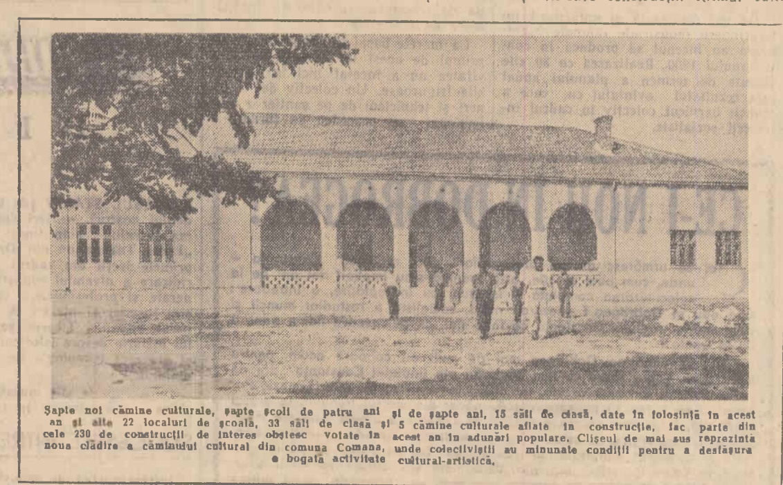
Sapte noi cămine culturale, șapte școli de patru ani și de șapte ani, 15 săli de clasă, date în folosință în acest an și alia 22 locuri de școală, 33 săli de clasă și 5 cămine culturale aflate în construcție, fac parte din cele 230 de construcții de interes obștesc votate în acest an în adunări populare. Cîștigă de mai sus reprezentarea noua clădire a căminului cultural din comuna Comana, unde colectivizii au minunată condiții pentru a deslășura e bogăția activitatei culturale-artistice.
