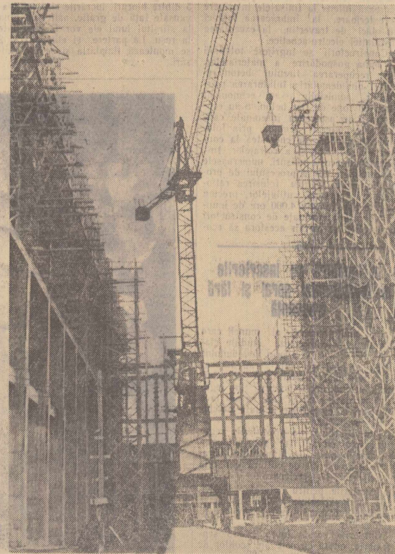
Construcția centralei electrice Marița-Est este în toi. Schelele se ridică tot mai sus, iar macaraua trebuie să-și întindă mult brațele pentru a duce muncitorilor de pe crestele zidurilor, materialele de construcție.
