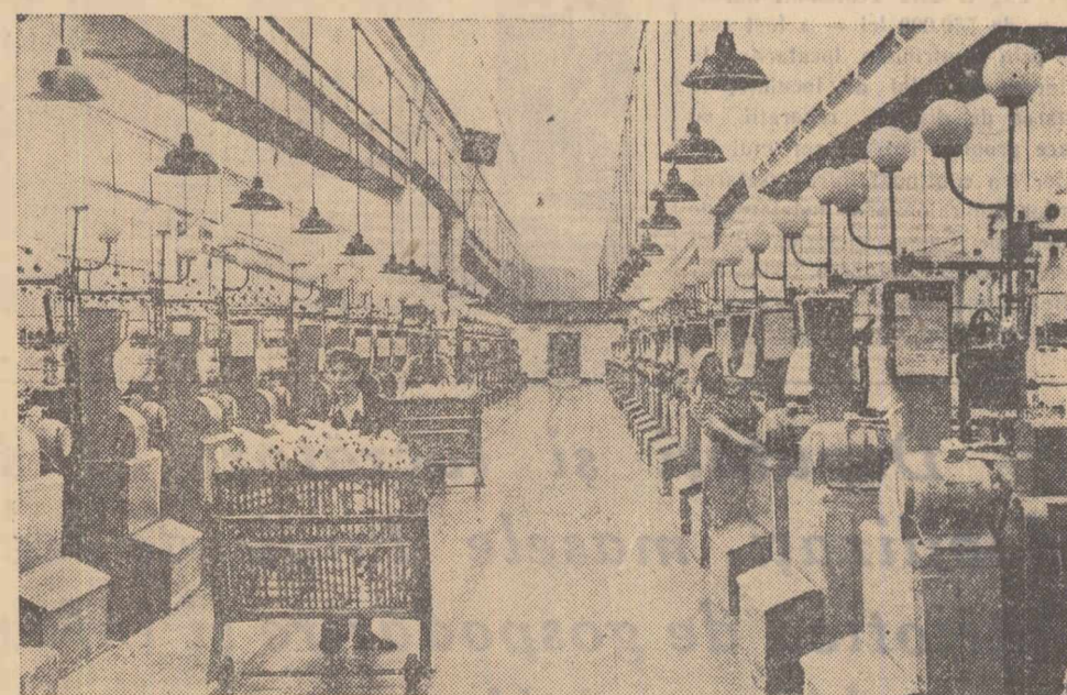
Fabrica „Tășatura” din Iași este una din întreprinderile din sectorul Industriei ușoare dezvoltată și modernizată în anii regimului de democrație populară. În clisue: Vedere parțială asupra uneia din noile secții, secția ringuri.
