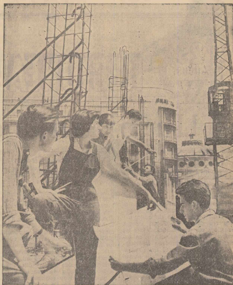
În ajutorul harnicilor constructori de pe marile șantiere din Capitală, vin și studenții Institutului de Arhitectură „Ion Mincu”, care în această perioadă își efectuează practica în producție. În clișeu: Un grup de viitori arhitecți conduși de tînărul Dan Voicu, lucrînd pe șantierul de construcții nr. 1 din Piața Republicii.
