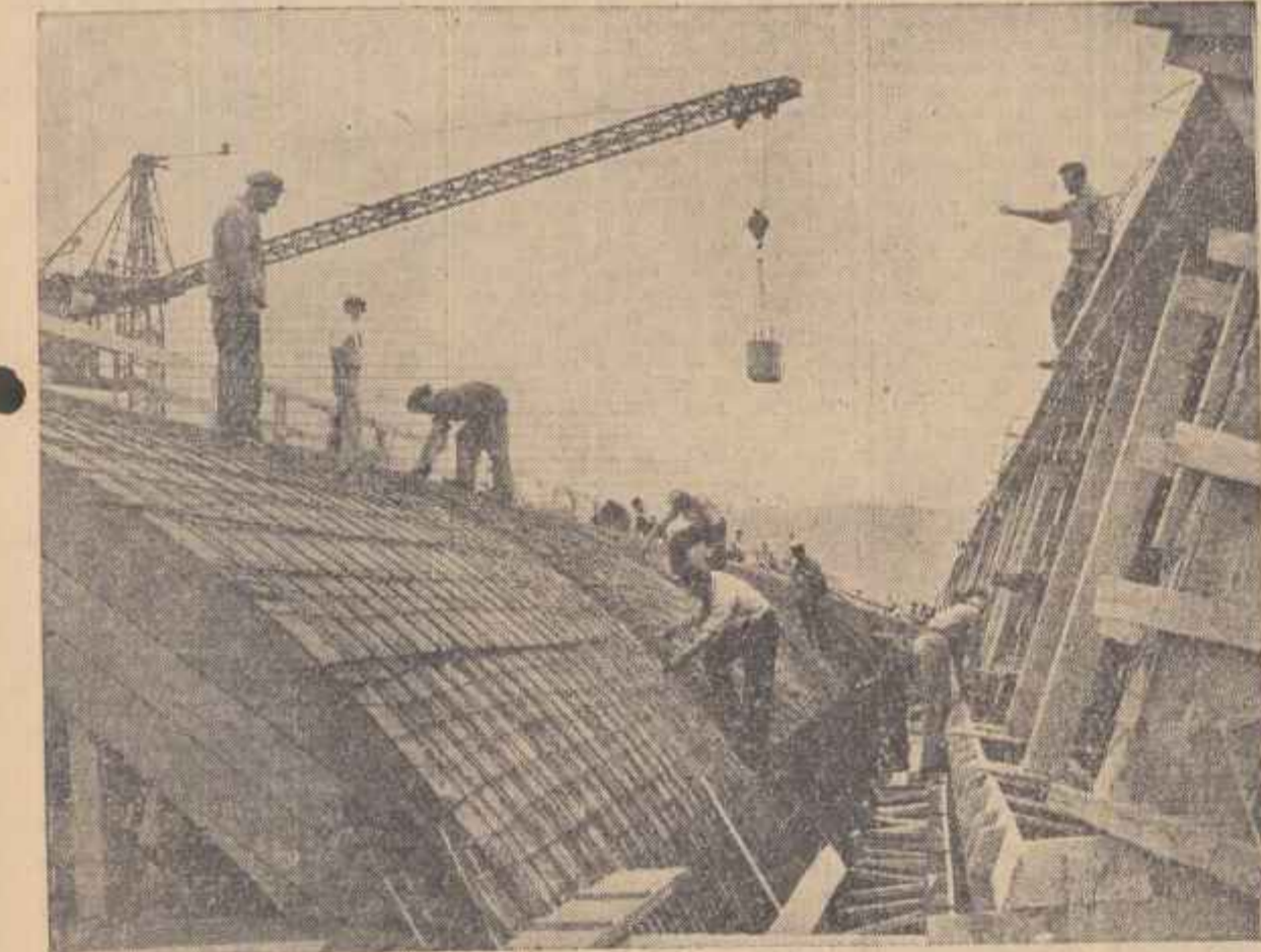
De cîtuva timp, în cadrul întreprinderii „Furul Rosu” din Tîlmaciu se construiește o nouă filatură modernă care va spori simțitor capacitatea de filare a fabricii existente. Lucrarea este executată de constructorii întreprinderii 565 din Mediaș. În clișeu: Echipa maiștrilor Andrei Stiger lucrează la montarea filaturii noi pentru acoperirea noilor filaturi
