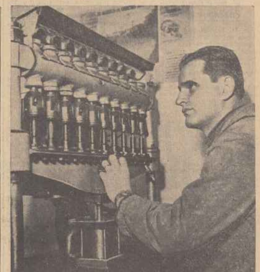
La fabrica de buji „Triumf” din Cluj se acordă o importanță deosebită îmbunătățirii calității bujiilor fabricate. În sprijinul acestei preocupări, vine un banc pneumatic de probă creat în întreprindere, la care este supusă unui minșios control fiecare bujie produsă. În clipă: controlorul tehnic de calitate Gheorghe Toader, lucrînd la acest banc de probă. Foto: NICU VASILE
