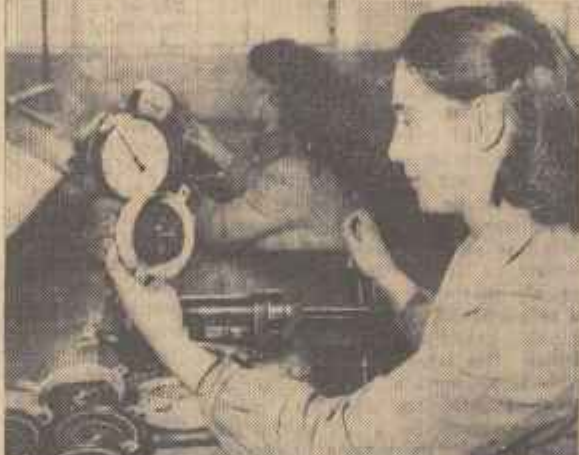
În stînga: În laboratorul metrologic tehnicianul Nicolae Florea face controlul final al comparatoarelor cu cadru. În dreapta: În secția de manometre Teodora Gheorghe execută operația de etalonare a manometrelor.
