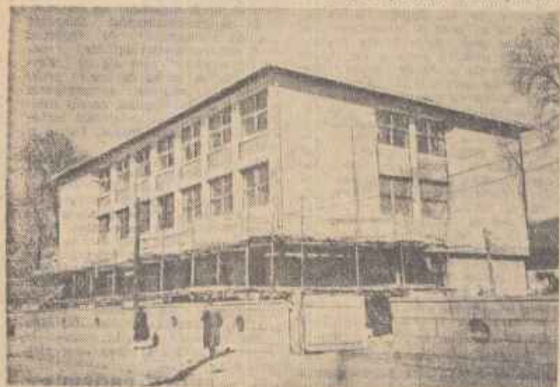
Substația de transformare a noului linii de troleibuz care se instalează în Cluj, construcție ce se află în stadiul de finalizare.
