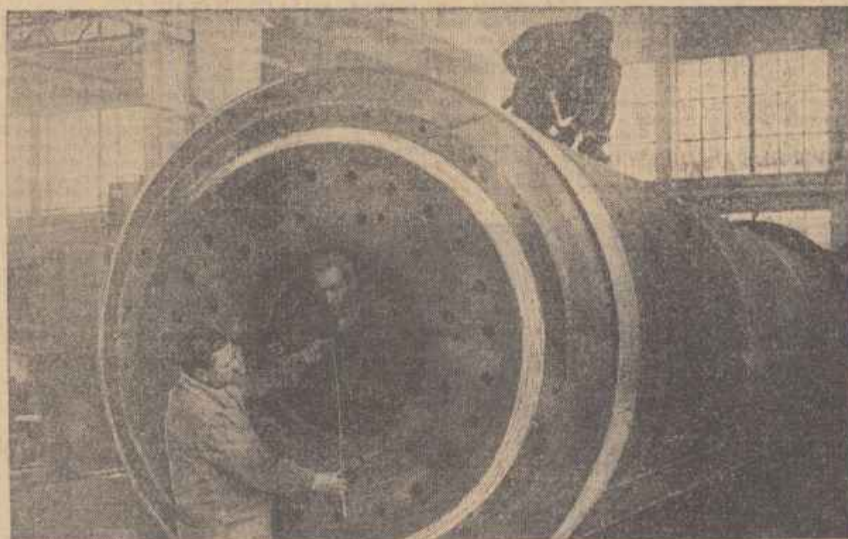
Produsele uzinei „Mao Tze-don din Capitală și-au căpătat o binemerită reputație. Printre numeroasele agregate care se fabrică în momentul de față aici, se află și morile de ciment pentru industria materialelor de construcție. În câmp: șeful de echipă Ion Mănășilă împreună cu cazangii Aurel Niță și Ștefan Răduțoiu de la secția cazangerie, lucrînd la tamburul unei astfel de mori — piesă importantă pe care se vor prinde ulterior toate mecanismele auxiliare.
