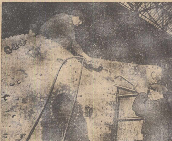
Cuprînși de avîntul muncii, sudorii Gh. Radu și Andrei Popa de la „Grivița Roșie” dau zor pentru a termina mai repede lucrările la cazanul locomotivei 140.001.
